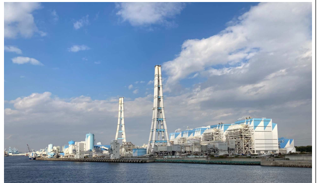
日本一の二酸化炭素排出源 JERA碧南石炭火力発電所
